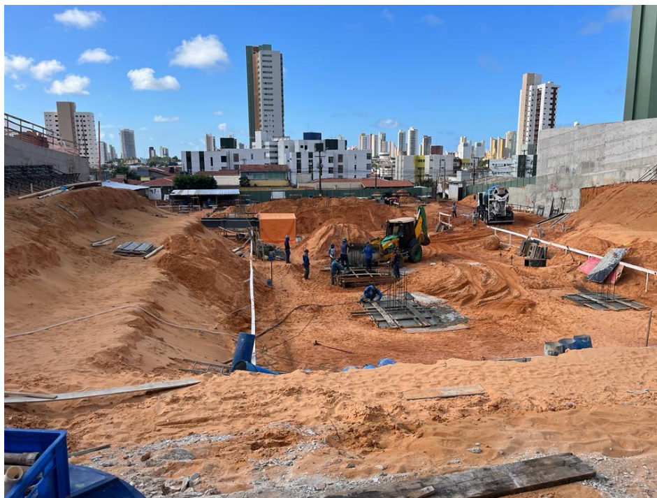
Figura 1: visão geral da obra.
