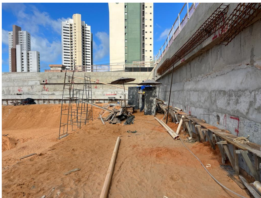
Figura 3: perfuração e instalação de tirantes.
