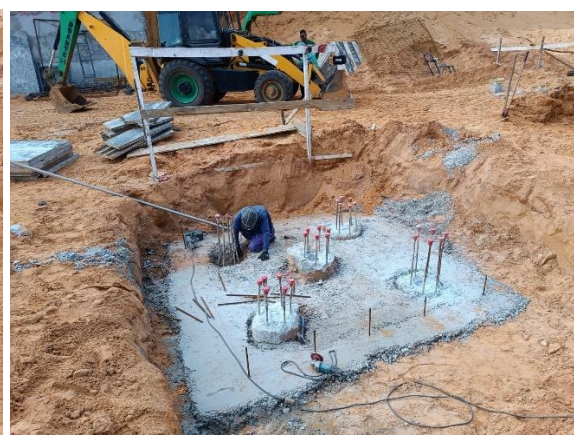
Figura 8: escavação para execução de blocos de fundação e preparação de bloco para concretagem.
