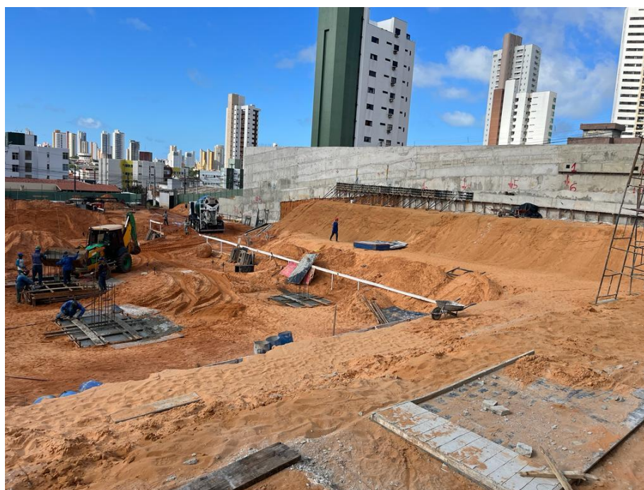
Figura 2: concretagem da segunda linha de tirantes.
