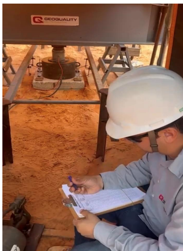
Figura 12: Prova de carga de estaca de fundação.
