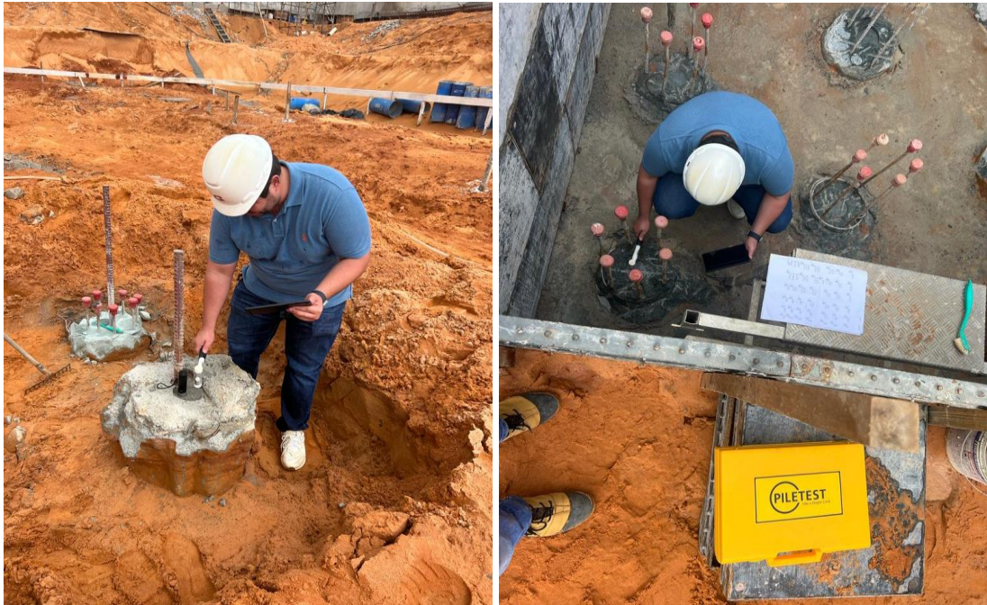
Figura 13 e 14: Ensaio de integridade física das estacas de fundação.
