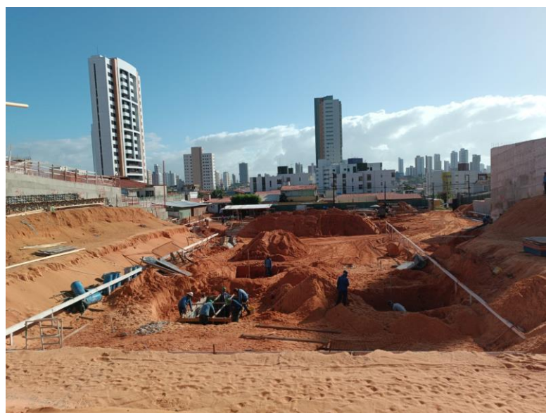
Figura 8: escavação para execução de blocos de fundação e preparação de bloco para concretagem.
