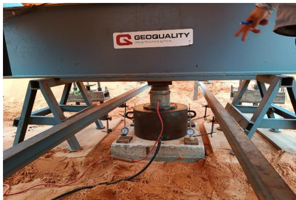
Figura 11: Prova de carga de estaca de fundação.
