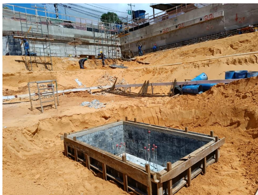
Figura 6: contenção, segunda linha de tirantes já preparada para a execução e revestimento para fechamento das estacas do muro de contenção.
