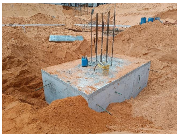
Figura 8: escavação para execução de blocos de fundação e preparação de bloco para concretagem.
